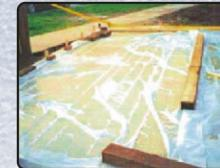
Poliüretan örtüler beton dökümünden yarım saat sonra beton kurumadan yüzeye serilmelidir. Kısaca hava ile teması kesilmesi sağlanmalıdır. En ekonomi ve pratigi naylon ile korumaktır.
