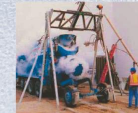
Resim 1: Betonun sıvı nitrojen ile soğutulması
