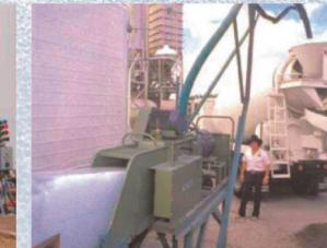
Resim 2: Beton karışım suyuna buz parçaları eklenmesi
